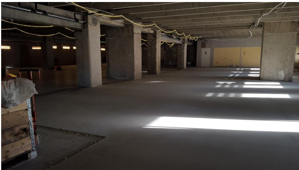
Figur 8 Krävande miljö för utsättning med totalstation
