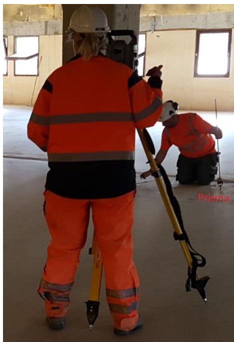
Figur 2 Utsättning med totalstation och prisma
